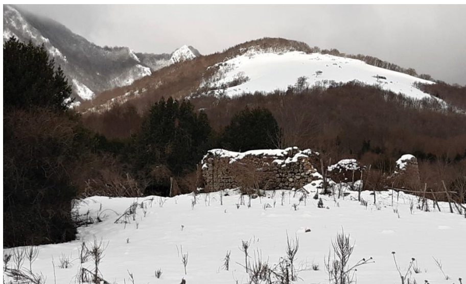
Fig. 2 – Piano di Montenero (Monti Picentini), edificio rurale in abbandono (m 1082)
